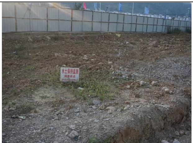
绿化区、边坡区水土流失情况评价：开挖基础周边堆土裸露，修建有临时排水沟与沉砂池，水土流失严重。
